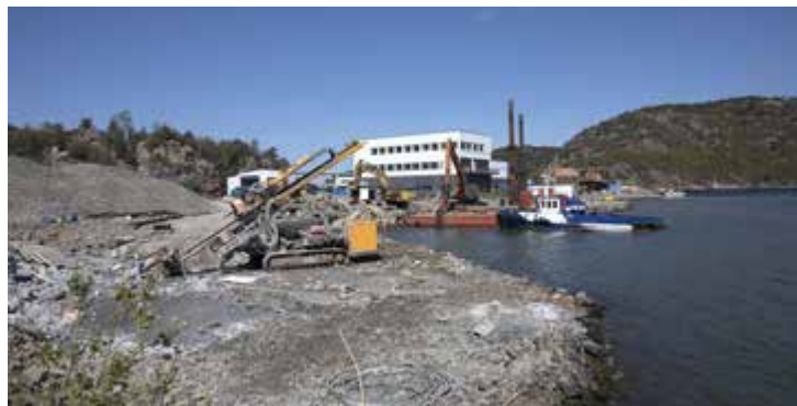
Dette er en del av den kommende rigghavna på Gismerøya, nærmere bestemt den innerste delen. Riggeierne krever at innseilingen ikke på noe sted må være grunnere enn 20 meter og smalere enn 100 meter. Ifølge Tor Henning Ramfjord er kravet oppfylt. FOTO: KJARTAN BJELLAND
